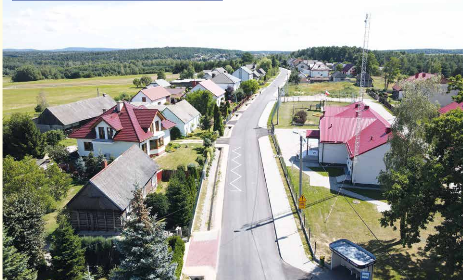
Przebudowana droga i nowy chodnik w Komórkach
