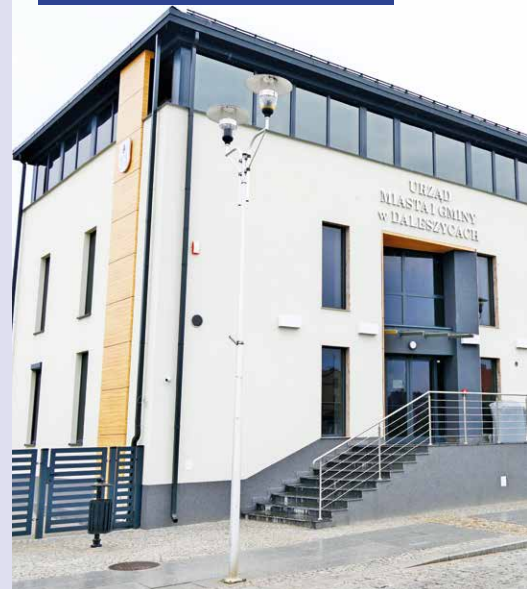
Termomodernizacja ratusza w Daleszycach
