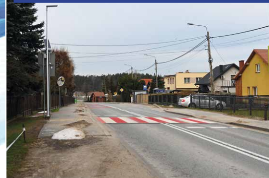
Aktywne przejście dla pieszych Borków 2021
