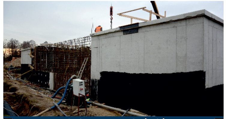
Rozbudowa oczyszczalni ścieków idzie zgodnie z planem
