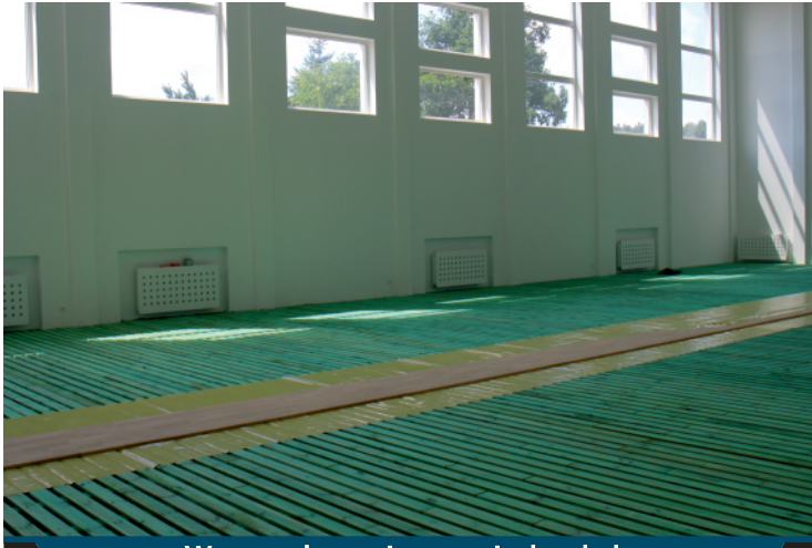
W nowych pomieszczeniach szkoły brakuje już tylko podłóg
